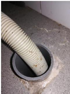
**Desagües de lavavajillas y lavadoras mal sellados, demasiado hueco entre ambos tubos.**
