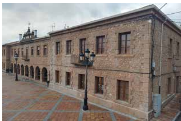
Arreglo Tejado y Fachada Ayuntamiento
