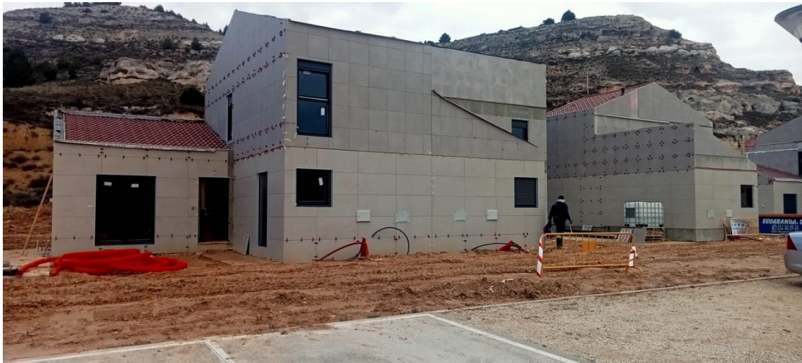
Vista desde el exterior
