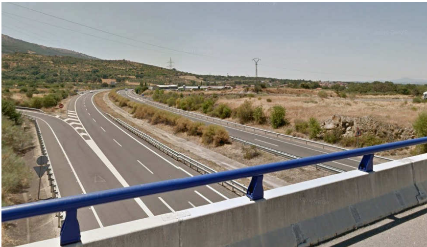
IMAGEN CONEXIÓN A-66 CON N-630.
