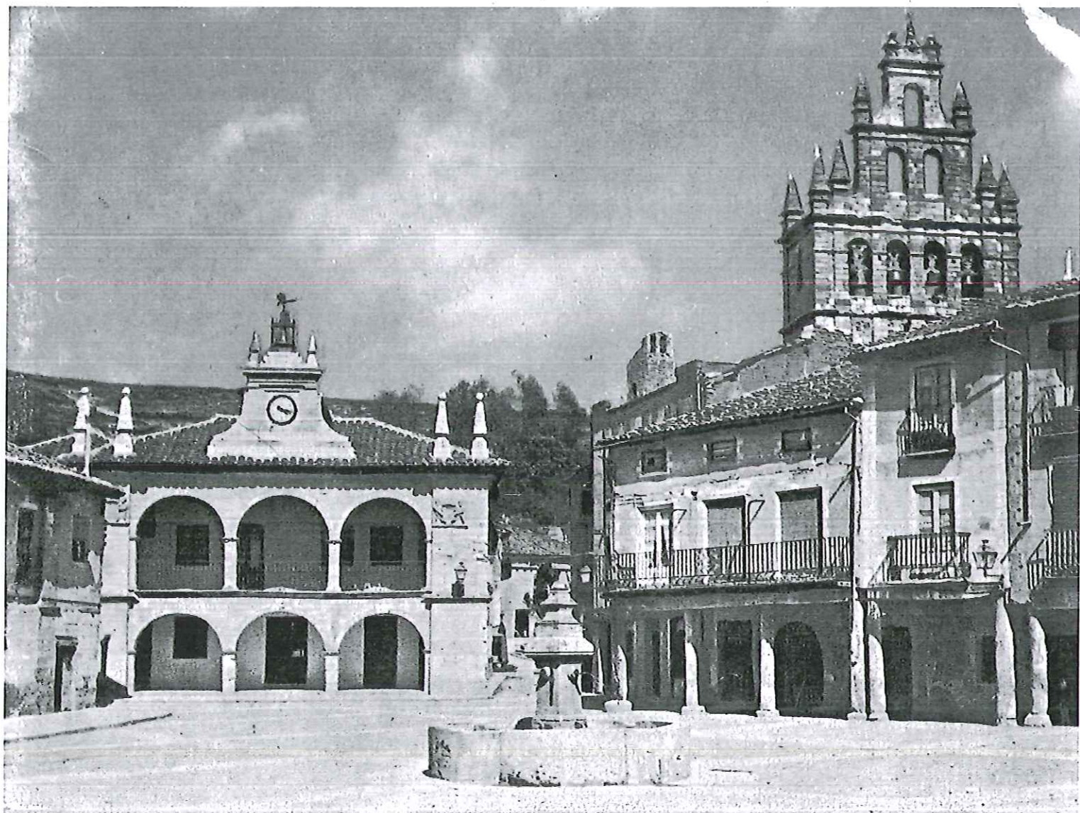
PLAZA MAYOR.-VISTA PARCIAL
