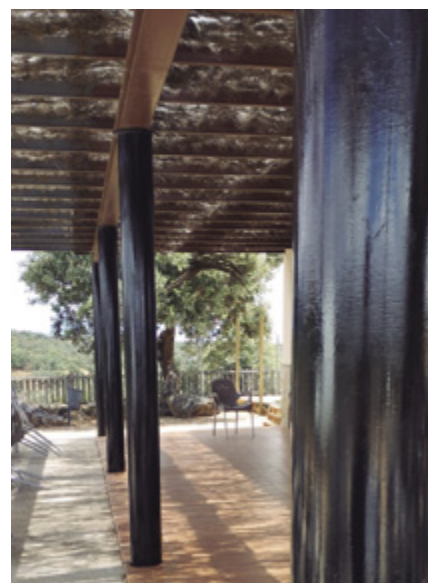
Porche Piscina - Después
