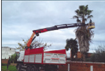
Grua con cesta
