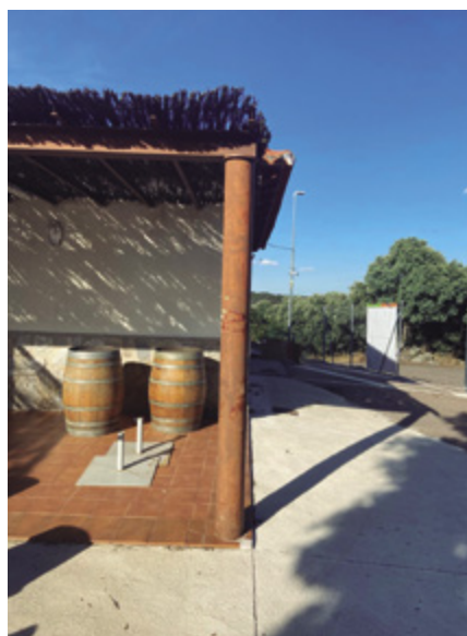
Porche Piscina - Antes
