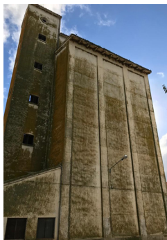
Antes de su restauración
