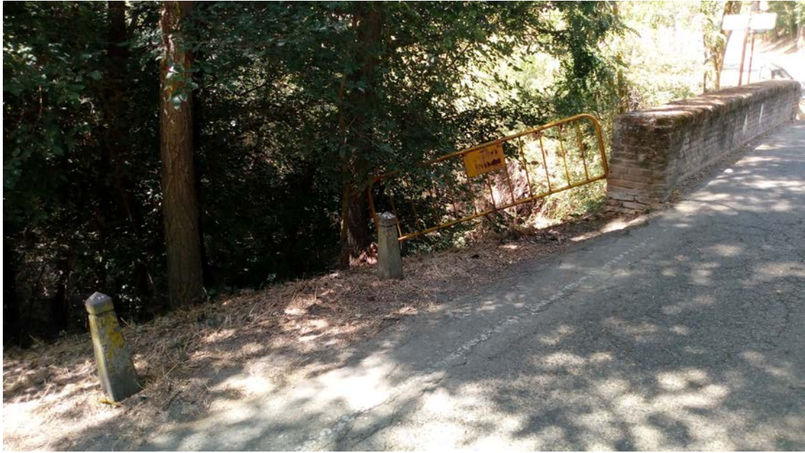
Pretel Oeste del puente histórico.
