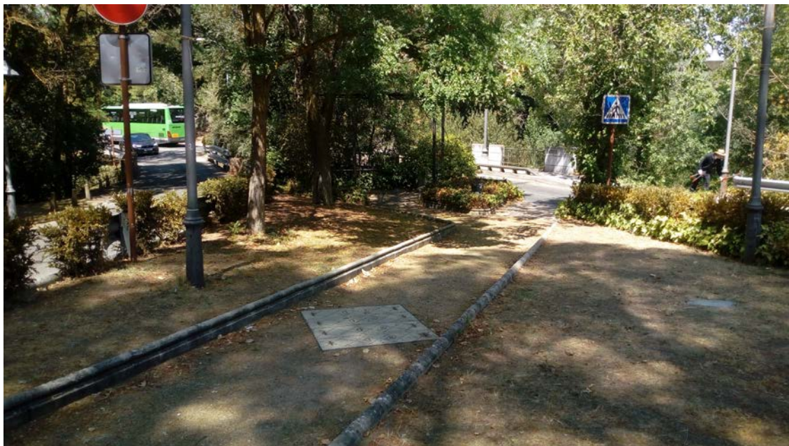
Parterre de la pérgola entre las calzadas de entrada y salida a Batres.
