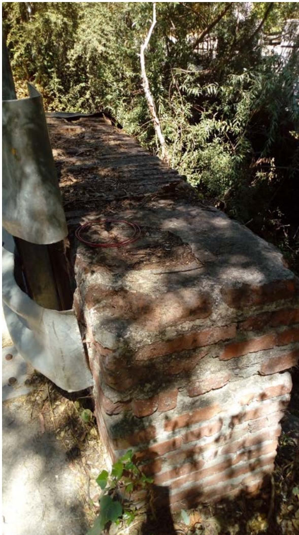
Resto del pretil Este del puente histórico.
