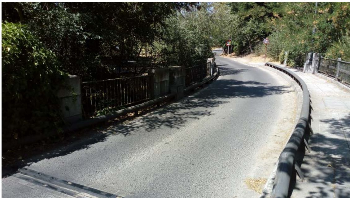
El puente nuevo sobre el arroyo de El Sotillo.
