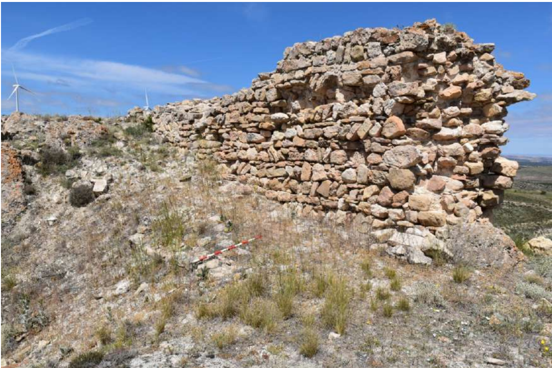
Lámina 83. Alzado interior de M.4. El jalón señala transversalmente la estructura M.9. Imagen de junio de 2024.
