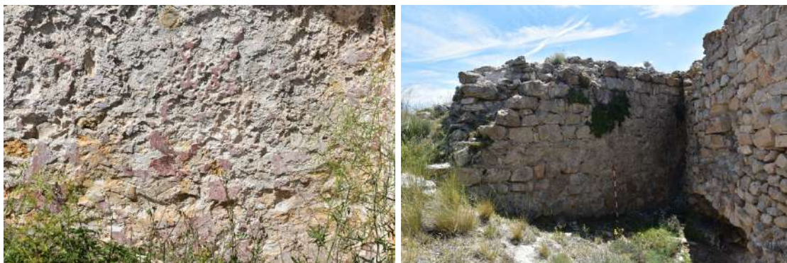
Láminas 90 y 91. Detalle del almagra del interior (izquierda) y vista del paramento exterior suroeste del aljibe (derecha).
