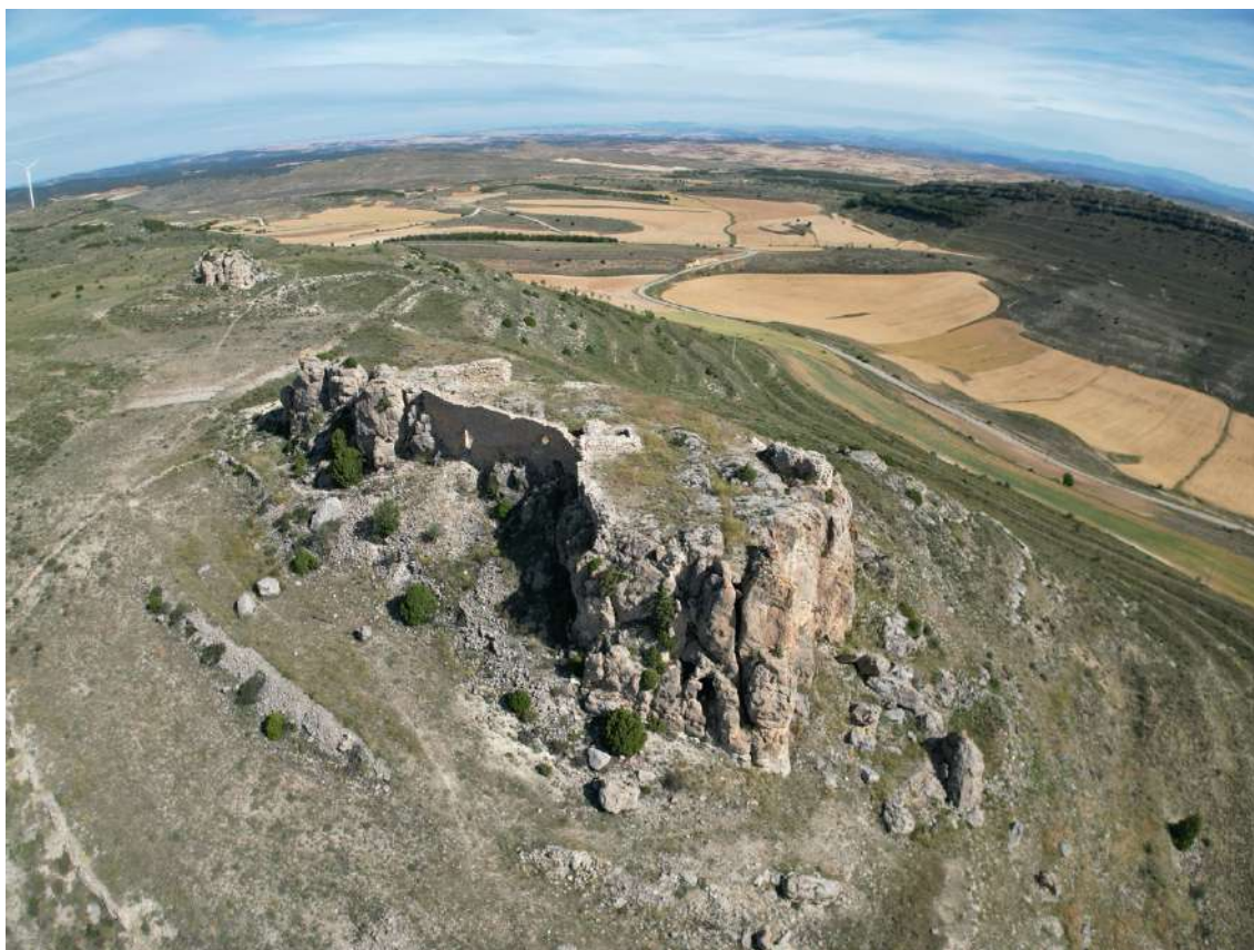
Lámina 56. Vista general del castillo desde el sur donde se aprecia la gran cantidad de material constructivo disperso por las laderas del cerro, especialmente junto al acceso principal.
