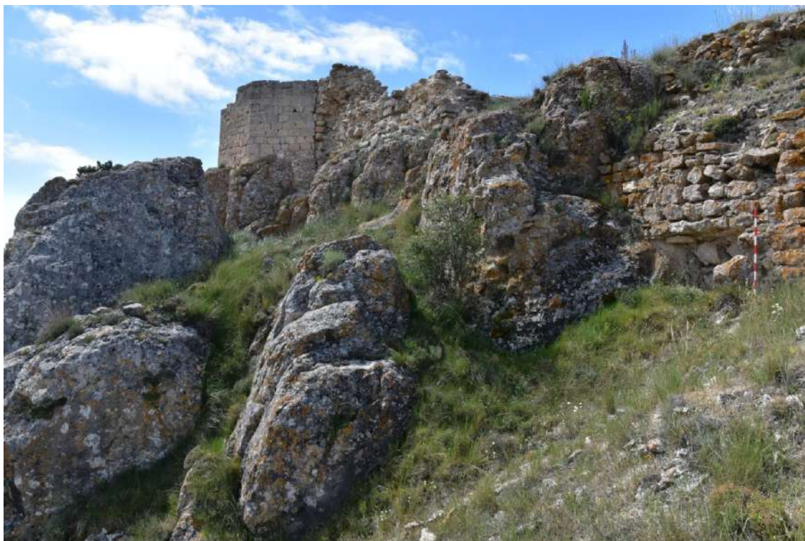
Lámina 86. Vista general de las estructuras M6 y M7, al fondo la torre pentagonal (T.1)
