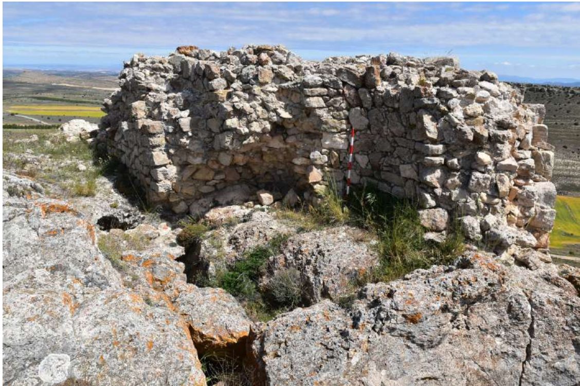
Lámina 74. Vista de la torre pentagonal por el interior, con obra de mampostería. En primer plano aparece la gran grieta vertical que hemos denominado sector B.2.
