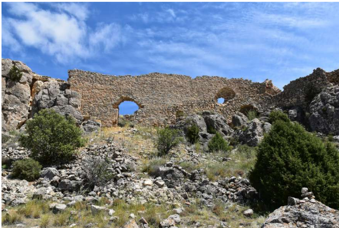
Lámina 76. Vista general de la estructura M2, por el exterior del castillo. Imagen de junio 2024.
