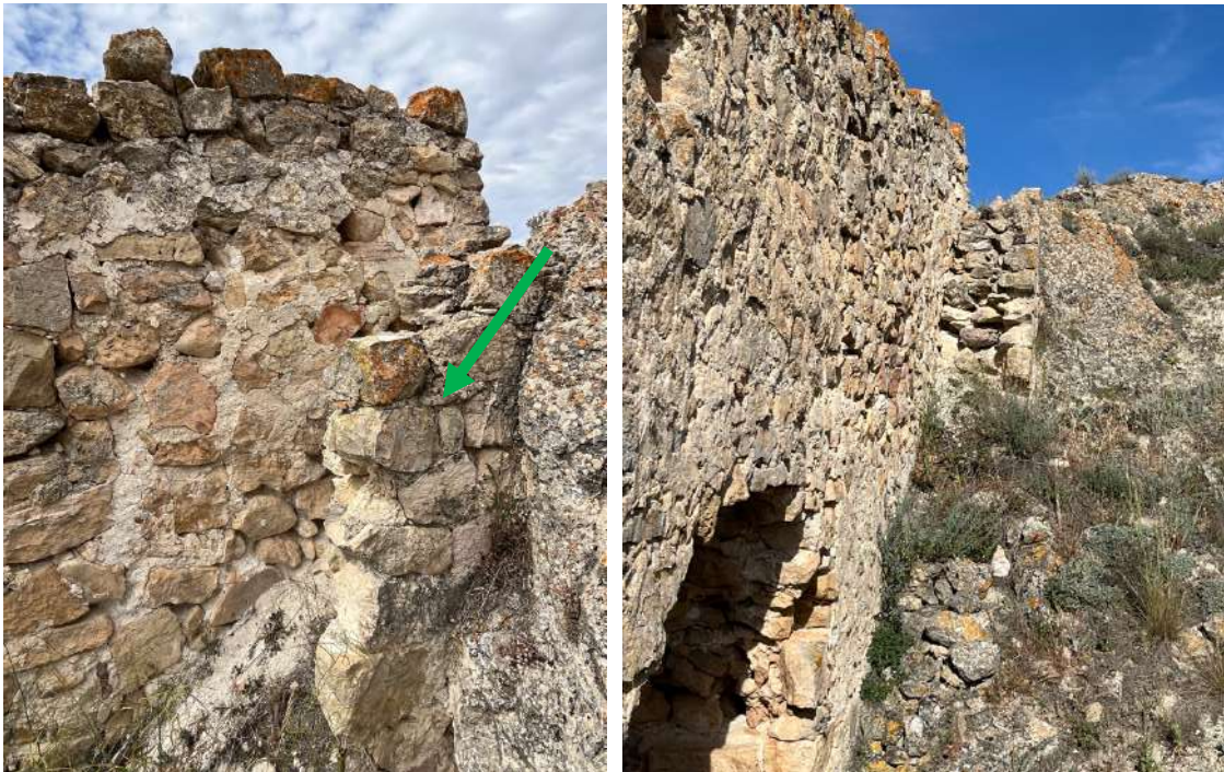
Láminas 53 y 54. Detalle del muro M8 adosado a intramuros contra el paño M2.
