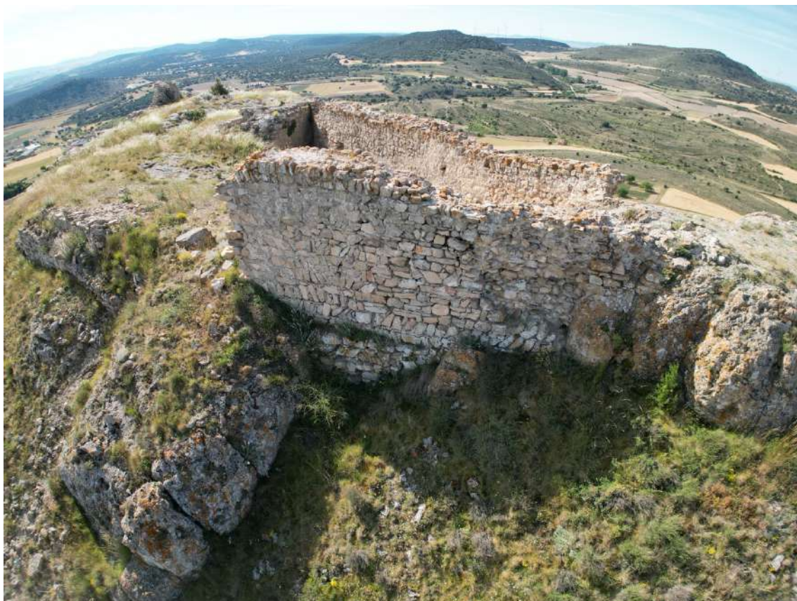
Lámina 32. Vista frontal del lienzo M4 apoyado sobre una zapata corrida.
