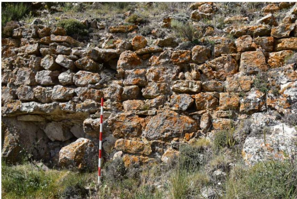
Lámina 88. Detalle del paramento M.6.2., con mampostería careada.
