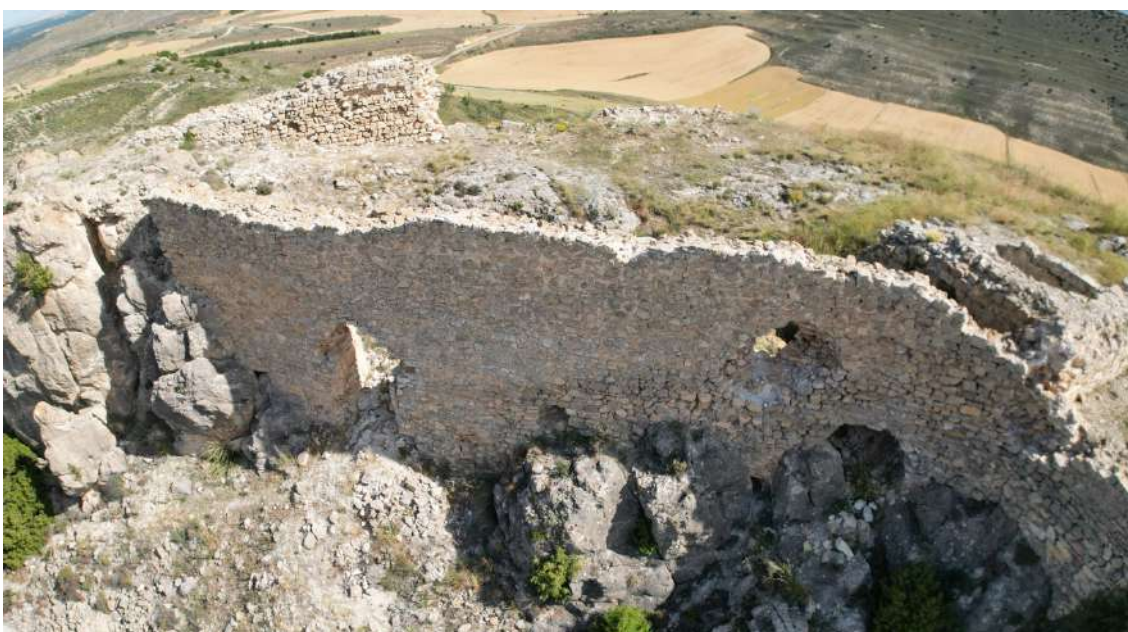
Lámina 45. Vista general del lienzo M2 desde extramuros.
