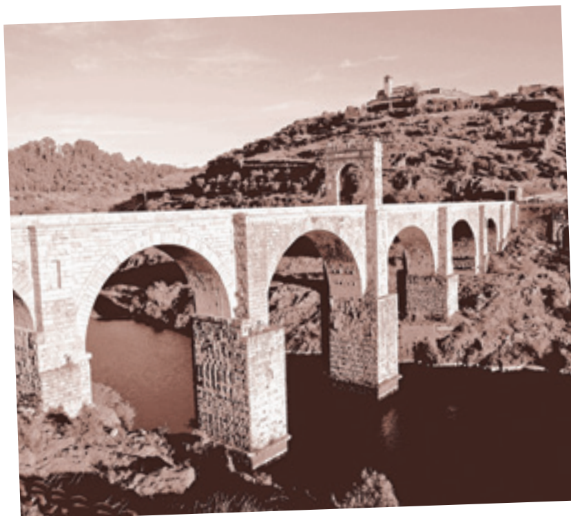
■ Foto 3. Puente Romano de Alcántara.
