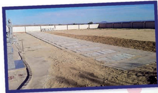
Junio - Construcción de nuevas sepulturas
