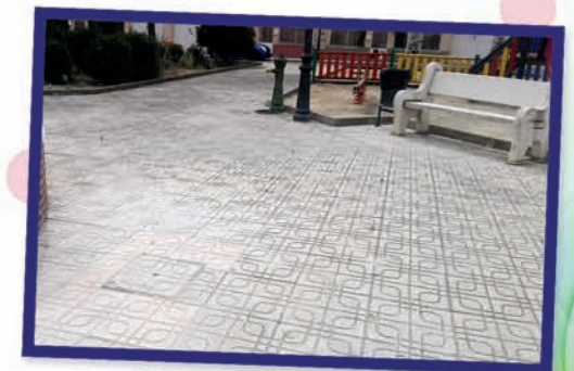
Agosto - Reparación pavimento Plaza Constitución
