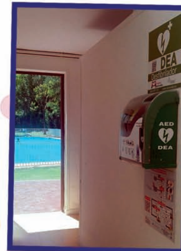
Agosto - Instalación desfibriladores Casa Cultura y Piscina
