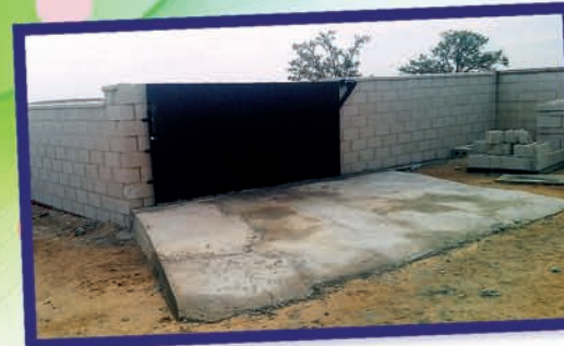
Julio - Construcción cerramiento para material de obra
