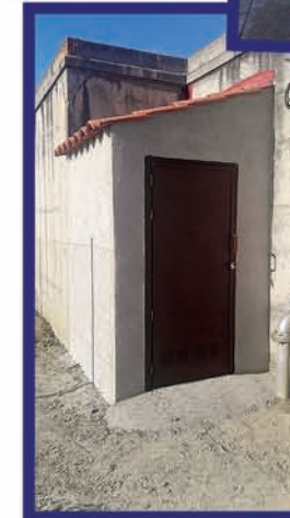
Julio - Construcción almacén de cloro en depósito de agua
