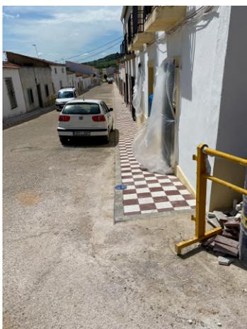
Se han llevado a cabo los trabajos de instalación de nuevas acometidas de agua potable, reparación de desagües y la pavimentación de nuevos
