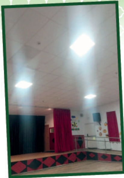
DICIEMBRE | Cambio falso techo salón Casa Cultura
