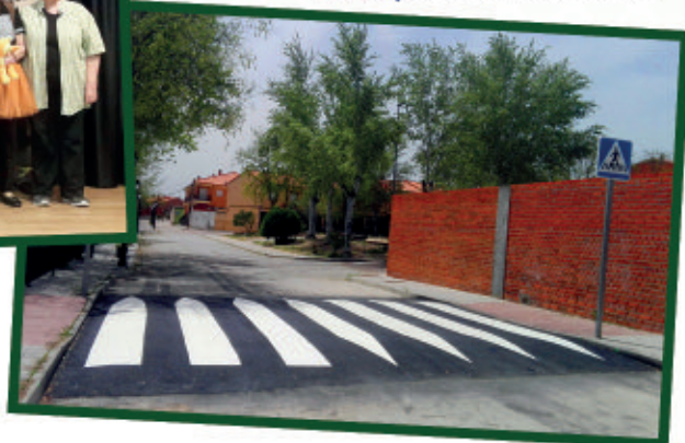
ABRIL | Instalación de badenes
