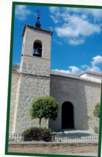
JUNIO-AGOSTO | Restauración y consolidación de la fachada sur de la Iglesia
