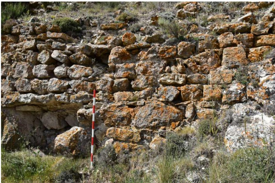
Lámina 88. Detalle del paramento M.6.2., con mampostería careada.
