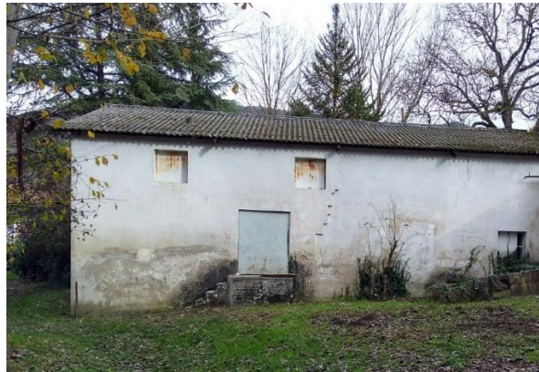
Figura 28. Situación actual de la zona de actuación en el punto 4.
