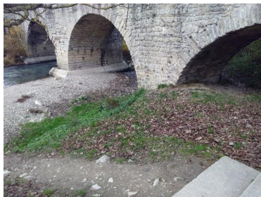
Figura 24. Situación actual de la zona de actuación en el punto 2.
