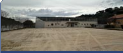
ARREGLO DE EXPLANADA DEL POLIDEPORTIVO
