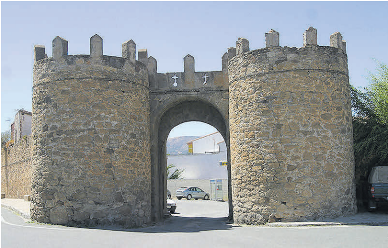
Un tramo de la Muralla ha acogido mejoras.
