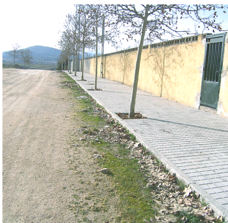
C/ de la Piscina antes del asfaltado previsto
