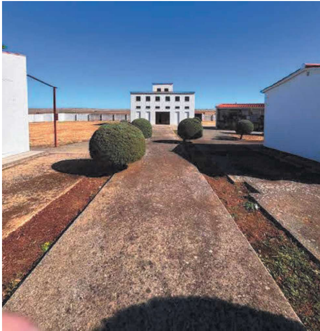
Solera de hormigón viario central (fotografía 05)
