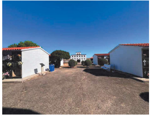
Viario central (fotografía 2)
