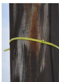
POSTE CASA SERRUCHO
