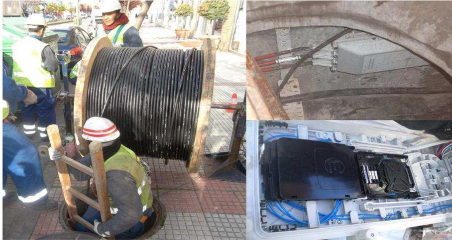
Ilustración 12. Tendido y empalme de cables en canalización.
