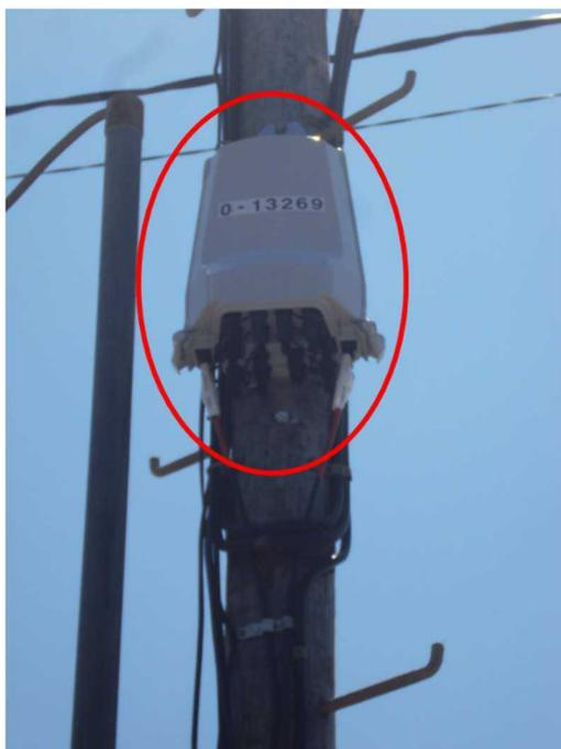
Ilustración 21. Caja terminal óptica (CTO) instalada en Poste.
