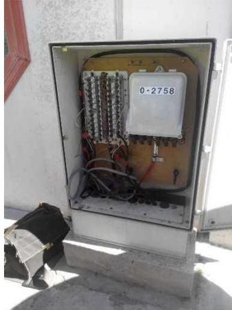
**Ilustración 22. Caja terminal óptica (CTO) instalada en Pedestal.**
