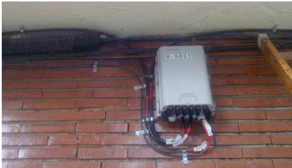
**Ilustración 18. Detalle Caja terminal óptica (CTO) exterior.**
