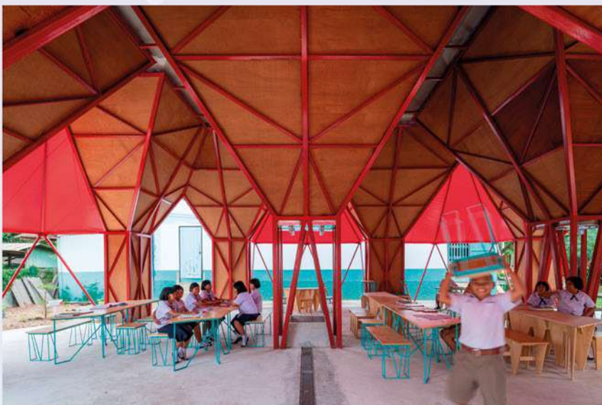
Pylonesque. Espacio multiusos recolector de agua. Baan Wang Toei School. Pareid Architecture.
