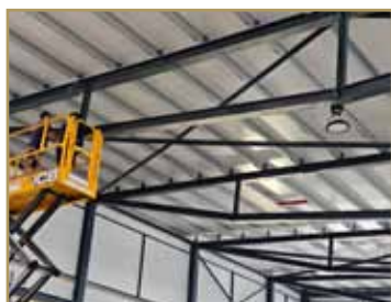
Obra en Pabellon Municipal
