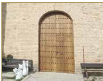
Instalación de la nueva puerta de la Iglesia
