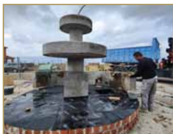
Instalación fuente en el Parque de Las Minas
