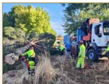
Retirada del pino caído en el arroyo
