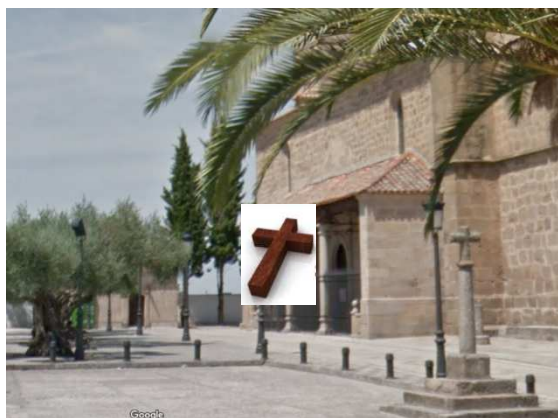
ESTACIÓN 14 - PORTAL DE LA IGLESIA
