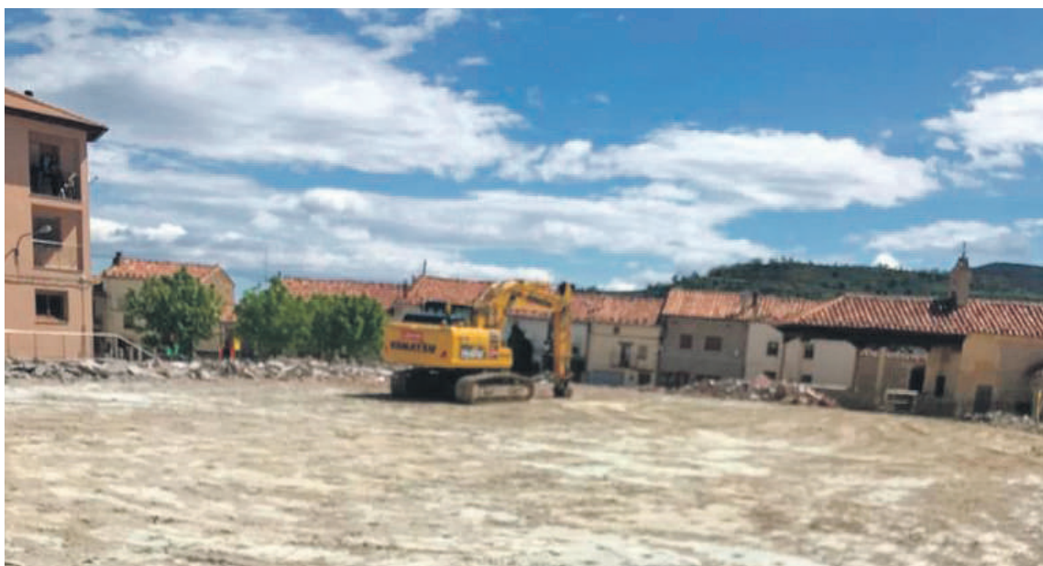
El Ayuntamiento de Cantavieja finalizará en los próximos días las labores de demolición del pabellón municipal. LA COMARCA
