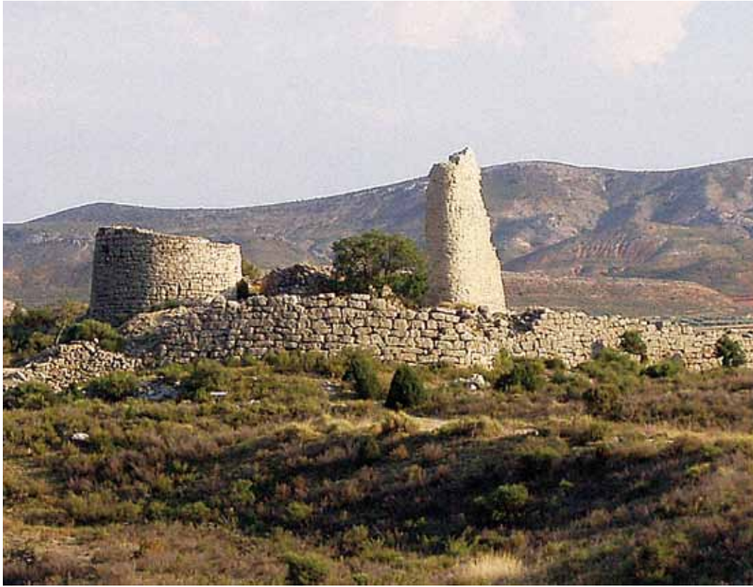
Fortaleza ibérica del Cabezo de San Pedro, en Oliete, con la torre en altura más antigua conservada en la península, más de 2 000 años de antigüedad. En la actualidad se realizan trabajos de estudio, excavación arqueológica y consolidación de estructuras
