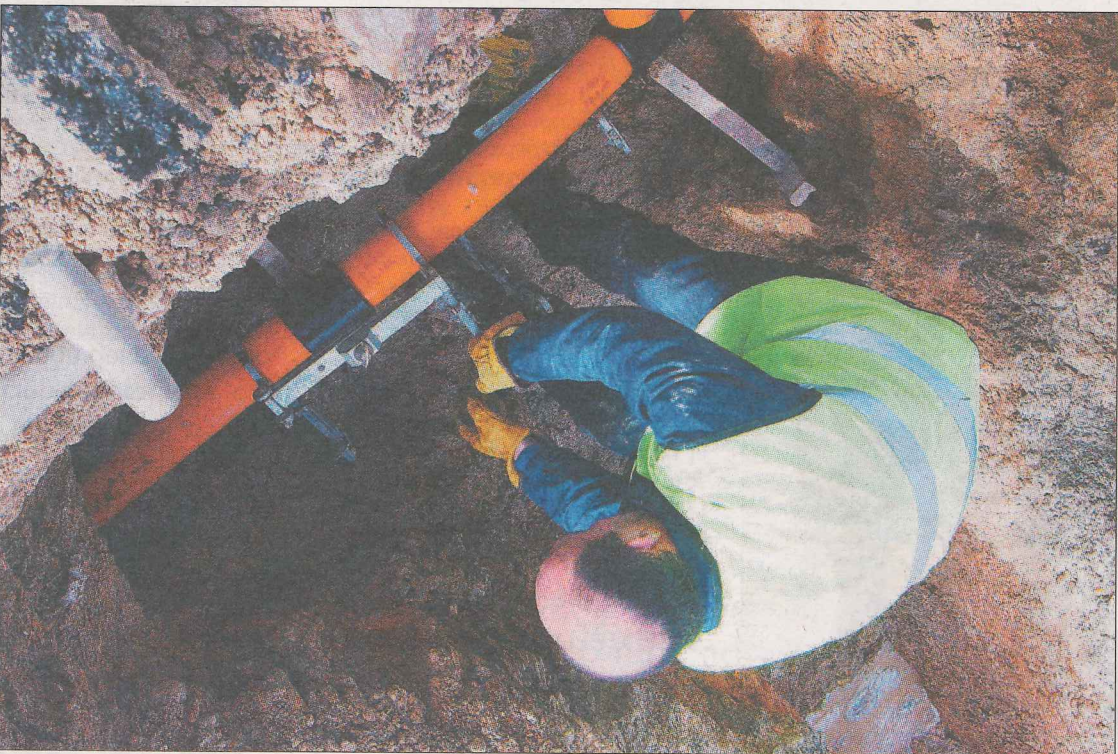
Imagen de archivo de la instalación de una tubería de gas natural. / CARLOS MUÑOZ
