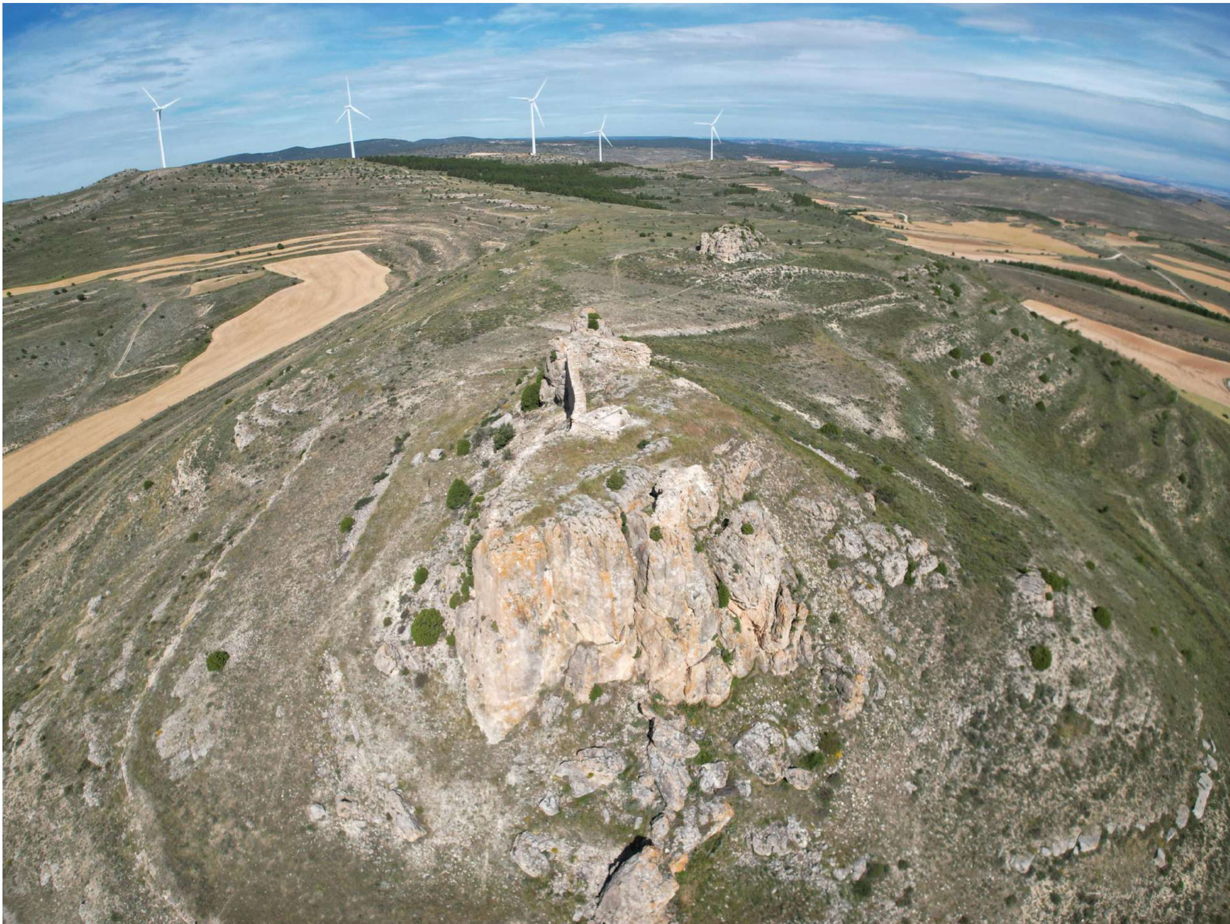
3 VISTA GENERAL DESDE EL ESTE
