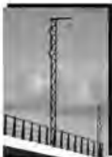
Torres para la electrificación del Ave Madrid-Barcelona
