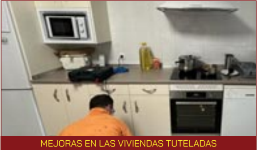
MEJORAS EN LAS VIVIENDAS TUTELADAS
