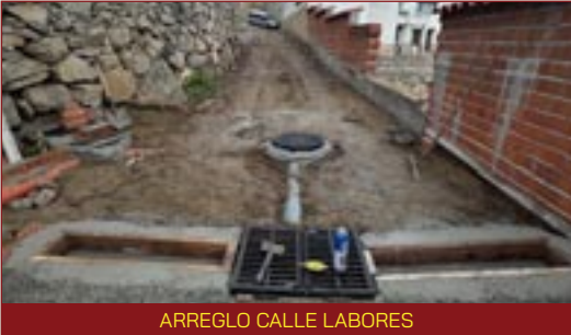
ARREGLO CALLE LABORES
