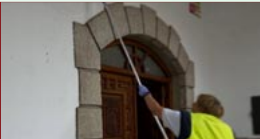
TRABAJOS DE PINTADO
