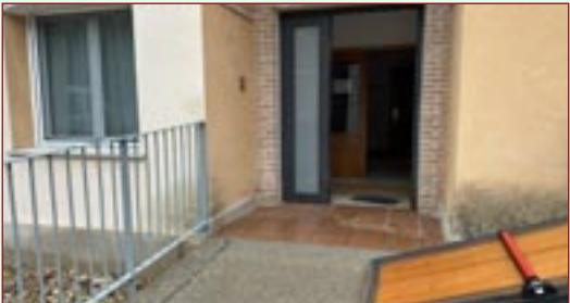
MEJORAS EN LAS VIVIENDAS TUTELADAS
